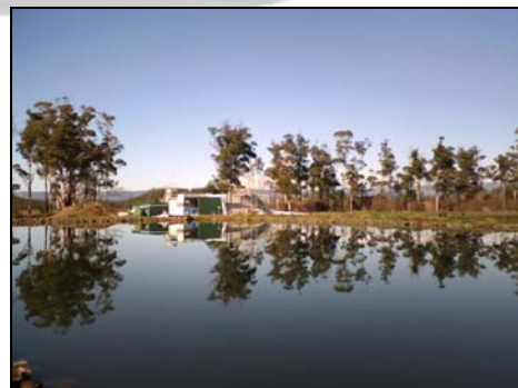
Sheffield STP (Tas)
